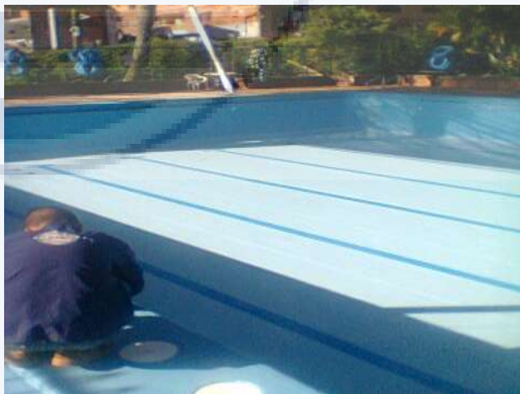
OBRA RECUBIERTA CON AQUAPOOL
